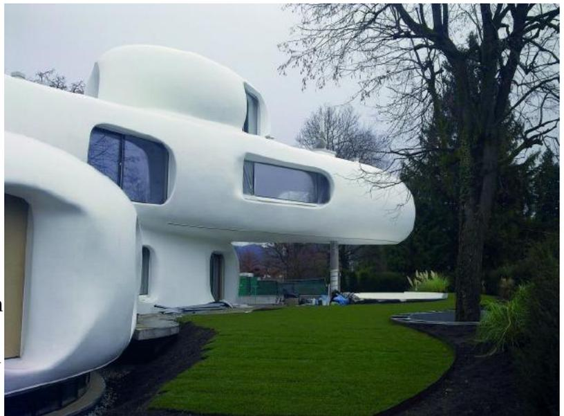
Die Sprüharbeiten wurden mit einer Gama Evolution VR– mit Datenlogger zur Dokumentation der Verarbeitungsparameter und Gewährleistung der Qualität ausgeführt. Die Durchführung erfolgte durch speziell für die Verarbeitung von Polyurea, ausgebildetes Fachpersonal.
