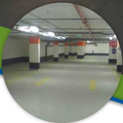
**POLYUREA im Parkflächenbereich.** Parkbauten in Stahlbetonbauweise unterliegen besonders hohen Belastungen. Dynamische Beanspruchungen durch den Verkehr, klimatische Einwirkungen sowie Feuchte- und Tausalzbeaufschlagung machen der Bausubstanz zu schaffen. Aus diesem Grund kommt es immer wieder zu gravierenden Schäden. Für Freiflächen und Parkhäuser sind nachhaltige Abdichtungskonzepte erforderlich.
