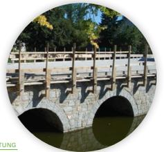
**Mauerwerkssanierung.** Die Aufgabe der Mauerwerksverfestigung ist die Rekonstruktion baufälligen, instabilen Mauerwerks. Mit dem Injektionsmedium – Kunstharz oder sehr mahfeiner Zementsuspension – werden Hohlräume und Risse verklebt. Auch in der potentiellen Schwachstelle Lagerfuge wird durch die Injektion die Mörtelfuge verfüllt, so dass das Mauerwerk homogenisiert und die Druckfestigkeit erhöht wird.
